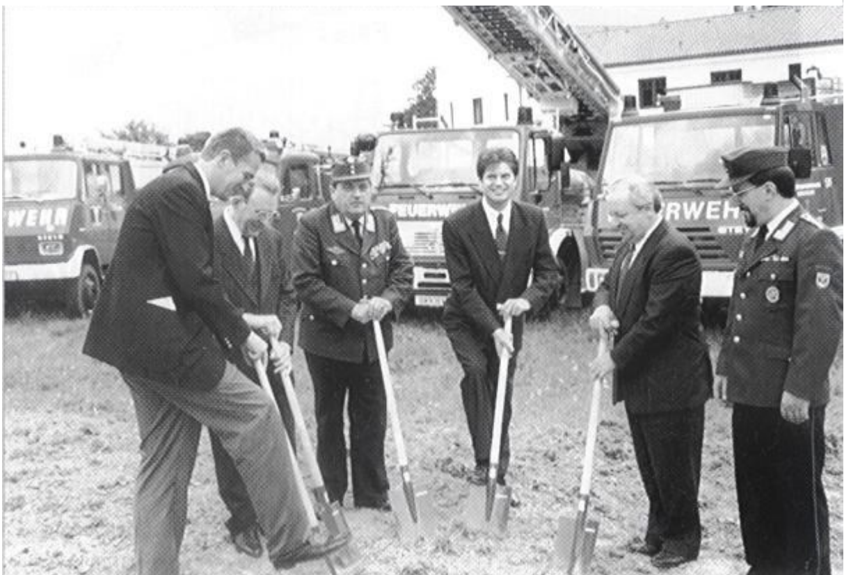
1993: Spatenstich für das neue Feuerwehrhaus
