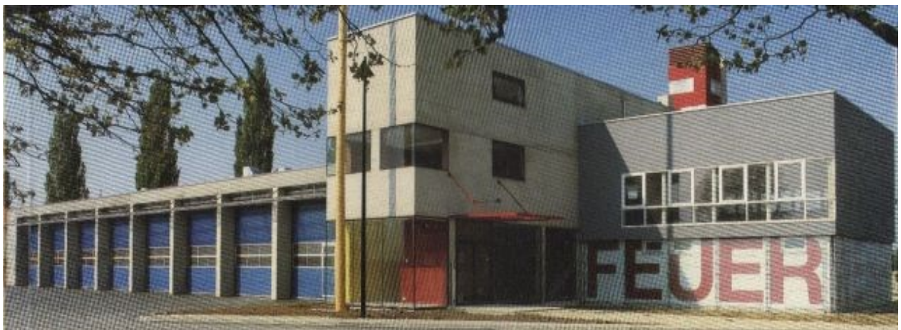
Das jetzige Feuerwehrhaus in seiner modernen Bauweise
